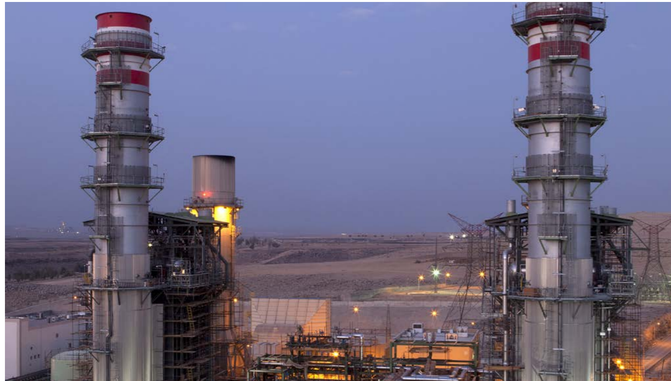
Κατασκευή Μονάδας παραγωγής ενέργειας στην Ιορδανία. Construction of a Combined Cycle Power Plant in Jordan.
