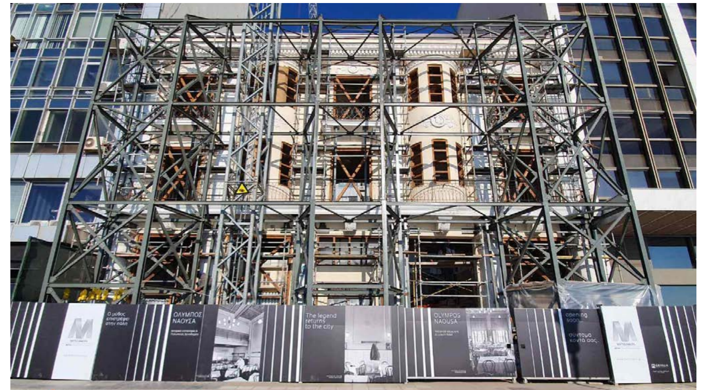
Ανακατασκευή διατηρητέου κτιρίου στη Θεσσαλονίκη. Reconstruction of a historical and listed building in Thessaloniki, Greece.
