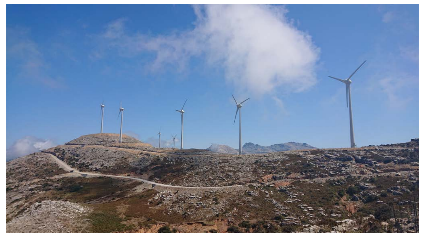
Αιολικό πάρκο στην θέση «Πύργος» στην Εύβοια, συνολικής ισχύος 15,3 MW Wind park at "Pyrgos" in Evia -Greece, with a total capacity of 15,3 MW.
