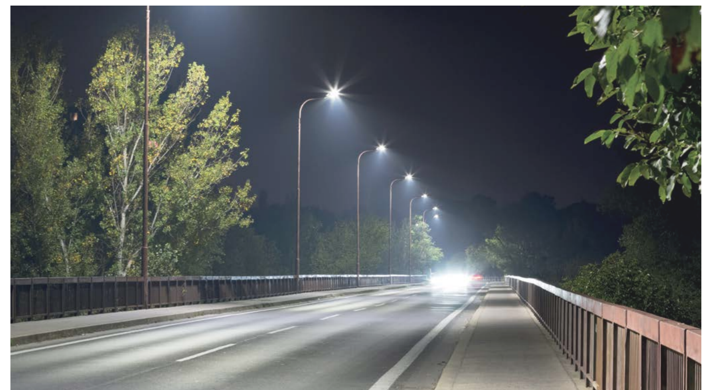
Αναβάθμιση του οδοφωτισμού στο Δήμο Βόλου. Energy Upgrade of street lightning in Volos Municipality, Greece.
